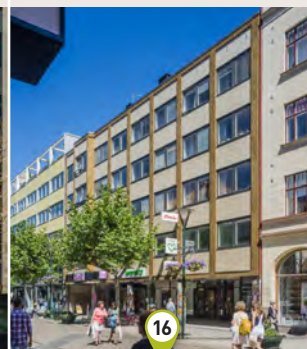
Fastighet Laxen 23 Adress S. Förstadsg. 34 Yta 7 482 m 2
