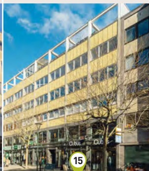
Fastighet Laxen 23 Adress S. Förstadsg. 32 Yta 2 347 m 2
