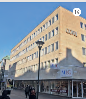
Fastighet Visenten 20 Adress S. Förstadsg. 26 Yta 3 497 m 2
