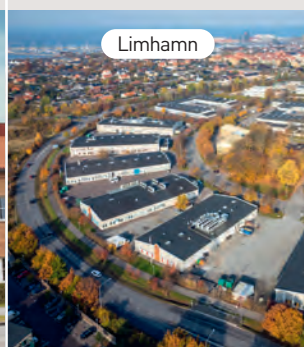
Fastighet Kupolen 3 Adress Krossverksg. 7-17 Yta 10 037 m 2
